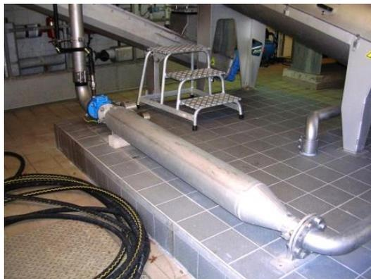
Bild 1: Originalinstallation des statischen Mixers vor der Schneckenpresse. Die Grafik zeigt den instabilen Betriebsverlauf welcher durch die unzureichende Konditionierung hervorgerufen wurde.
