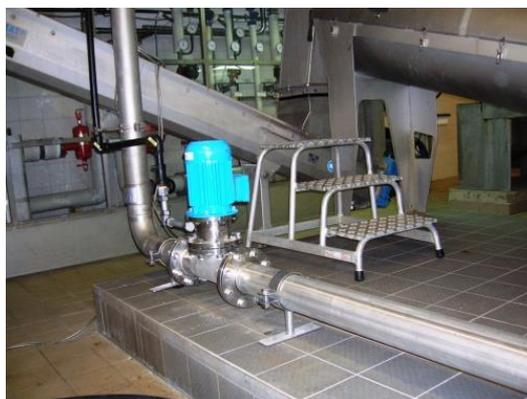
Bild 2: Einsatz des Flocmix IM 3 anstelle des statischen Mischer. Die Grafik verdeutlicht den gleichmäßigen und stabilen Betrieb der Anlage mit Flocmix.
